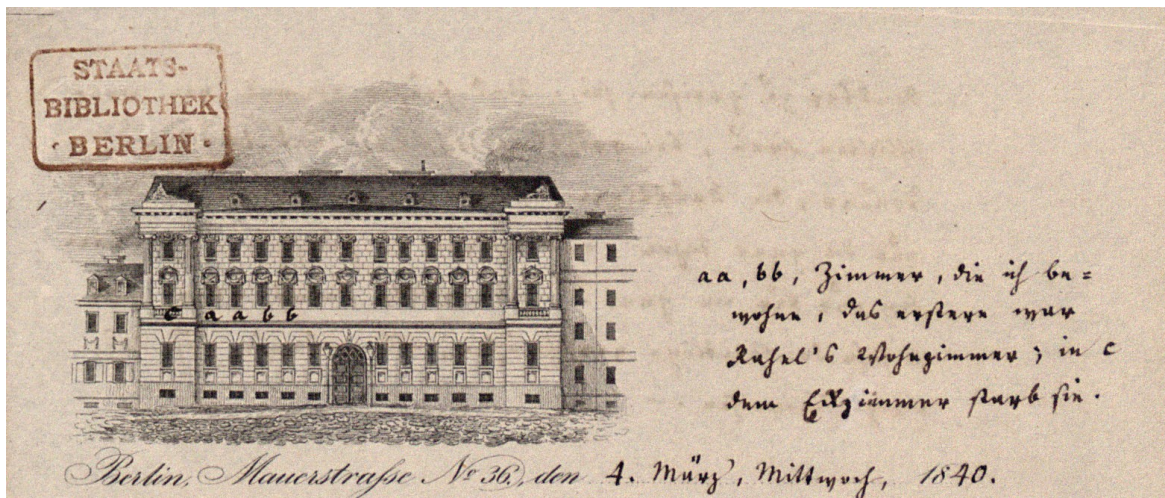
Von Karl August Varnhagen kommentierte Ansicht der Mauerstr. 36 (Briefkopf, 1840) Tagesblätter, Jagiellonische Bibliothek , Krakau
